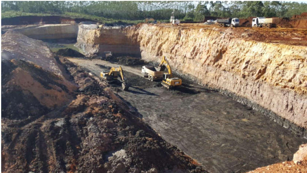
Figura 10: Desmonte mecânico e carregamento da camada de carvão em caminhões basculantes.
