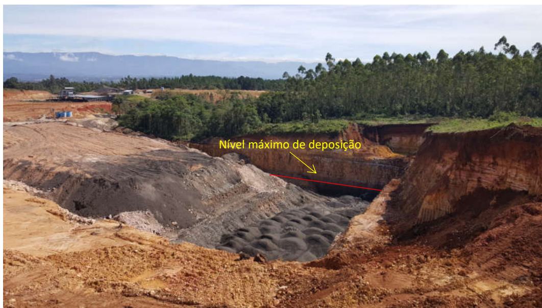
Figura 15: Deposição de rejeitos do aerosseparador no interior da cava com indicação do nível máximo de deposição.
