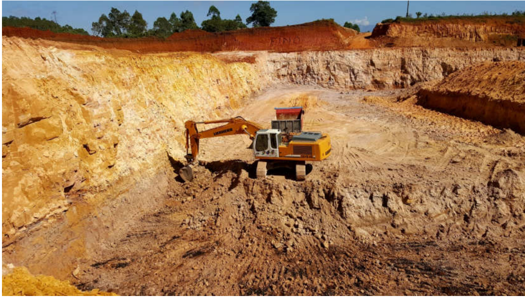
Figura 8: Remoção do banco de arenitos e do siltito de cobertura da camada de carvão Barro Branco.
