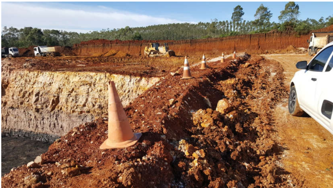
Figura 6: Remoção da camada argilo-arenosa de cobertura na Mina Santana Céu Aberto.
